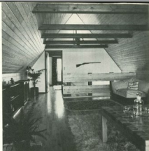
Gulvbelægning i tagetagen har bræddebelægning løst lagt op i kippen. I baggrunden ses trappen til stueetagen og dørne til forstueoverdækningen. Tagetagen er ikke indstøbt ved husets overdragelse, men gulvbelægning, malmgulvbelægning, vægbeklædning og søm står parat.
